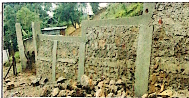
Foto 5 aquí se ve el avance y parte de la entrada
