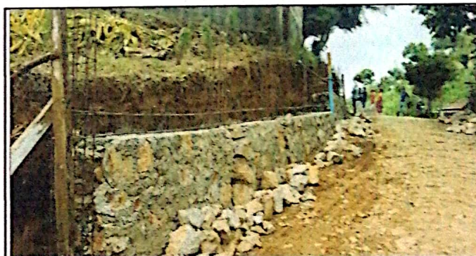
Foto 4: otra fotografia donde se ve como se esta quedando el muro
