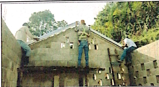
Foto 2: aquí se observa la colocacion de infraestructura de la cocina
