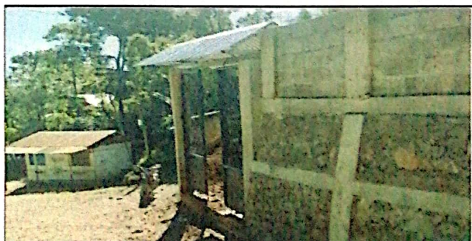
Foto 6: Colocacion de entechado y portón de la entrada
