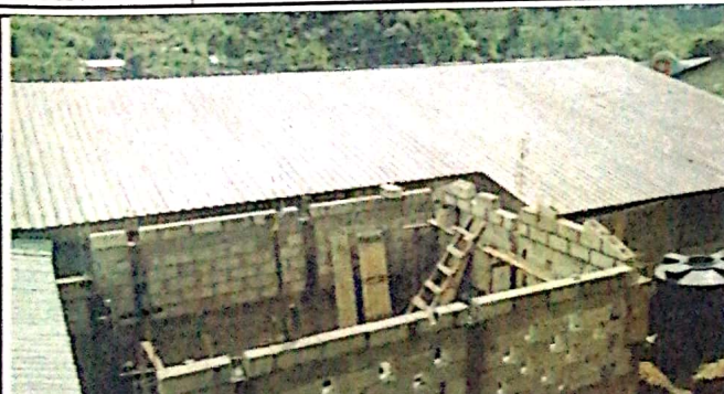
Foto1: Se observa la colocacion de block de la cocina
